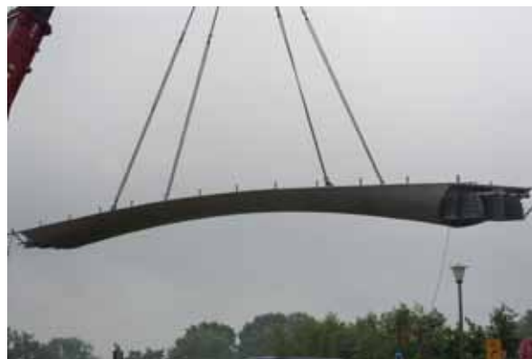
Montage der Stahlstruktur © Hermann Willers
